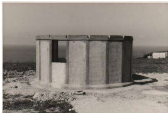
L'Osservatorio in costruzione
