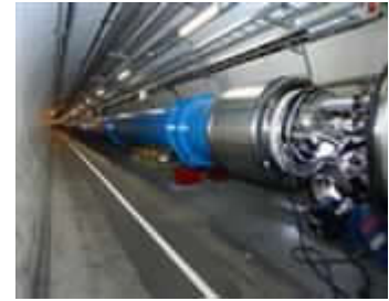
Interconnessione dell'ultimo settore del LHC nel tunnel (@ CERN )
